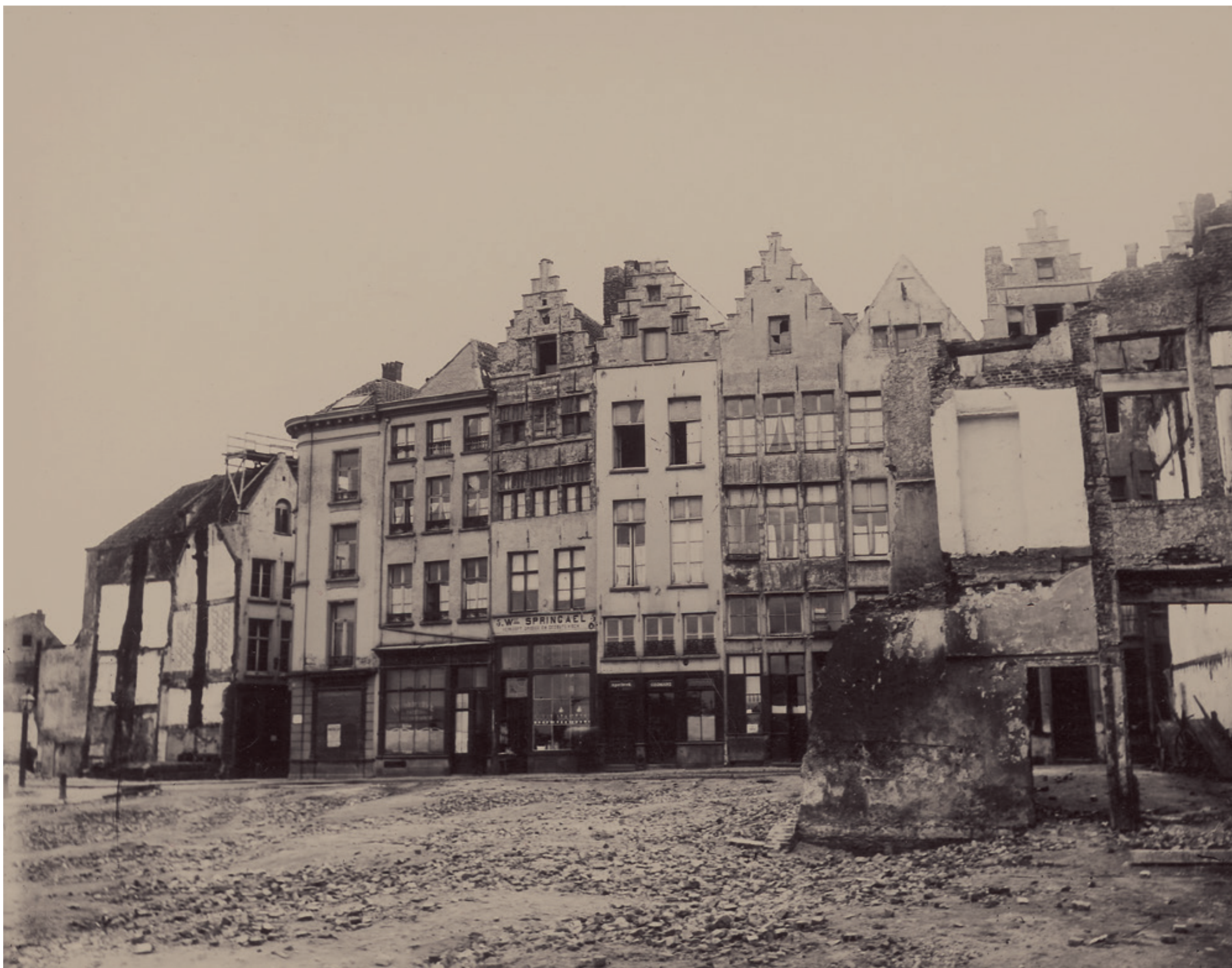
223. Fotograaf onbekend. Afbraakwerken in de buurt van het Steen
