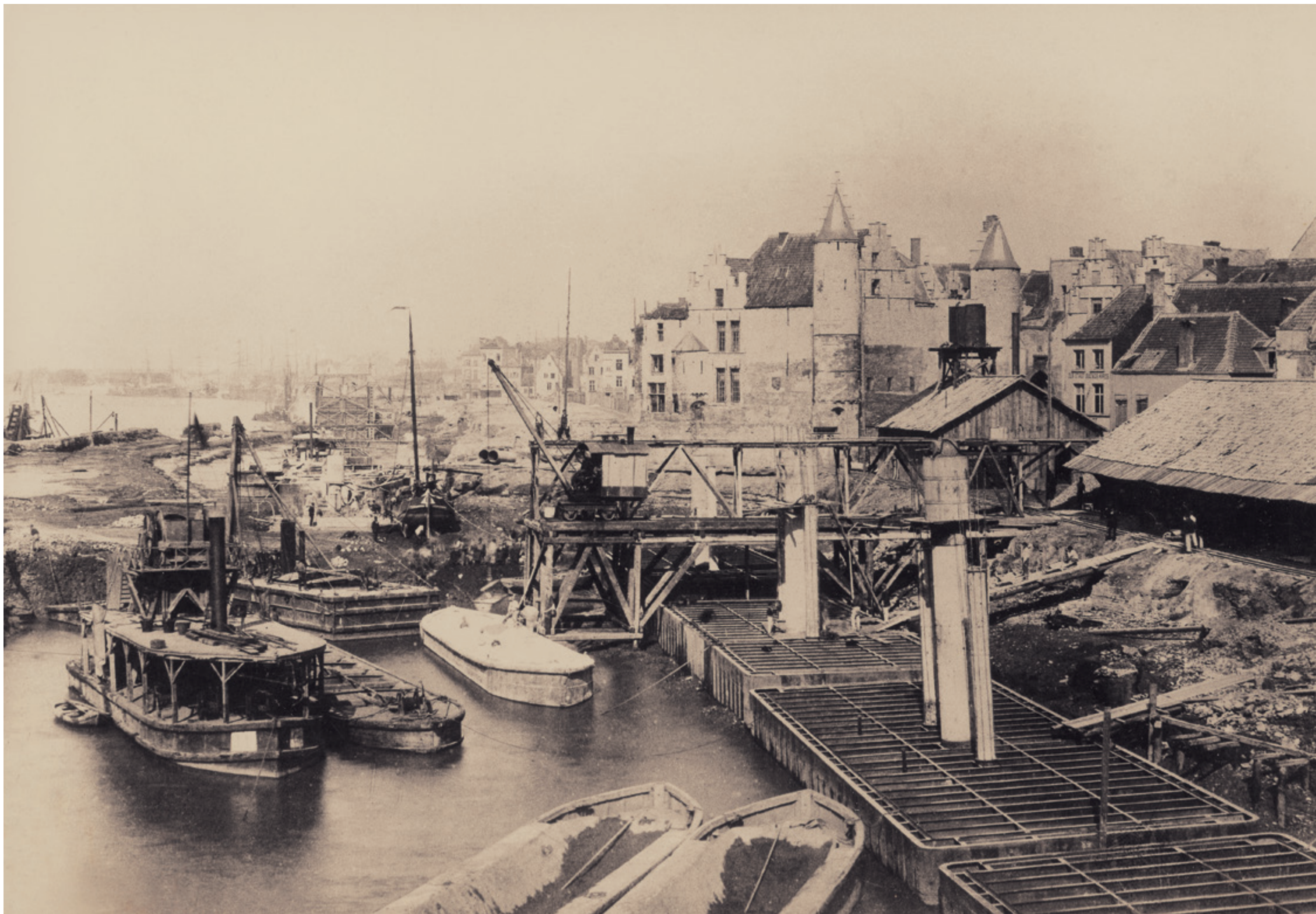
228. Fotograaf onbekend. Aanleg van nieuwe kaaien ter hoogte van het Steen
