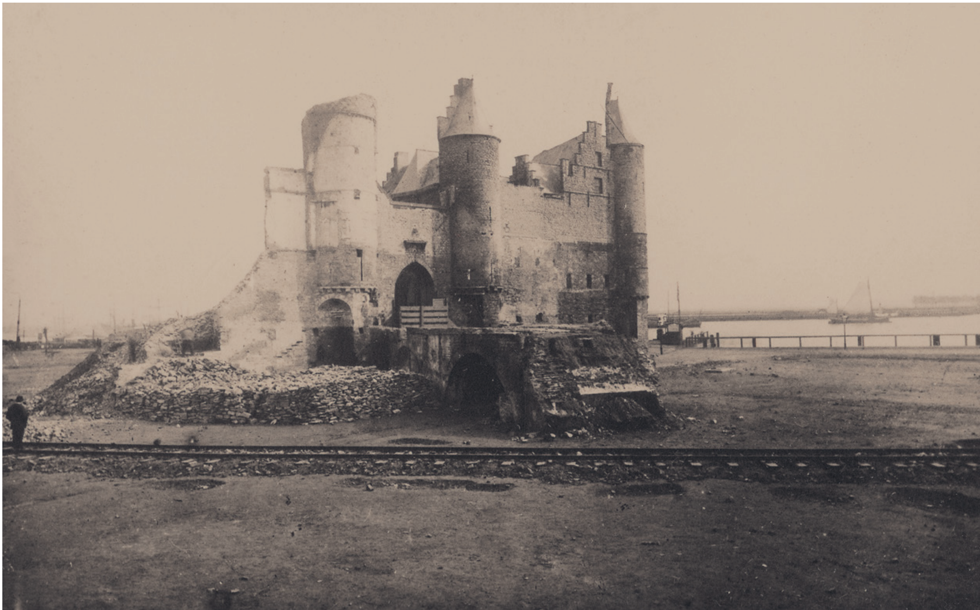
216. Fotograaf onbekend. Het Steen na de afbraakwerken
