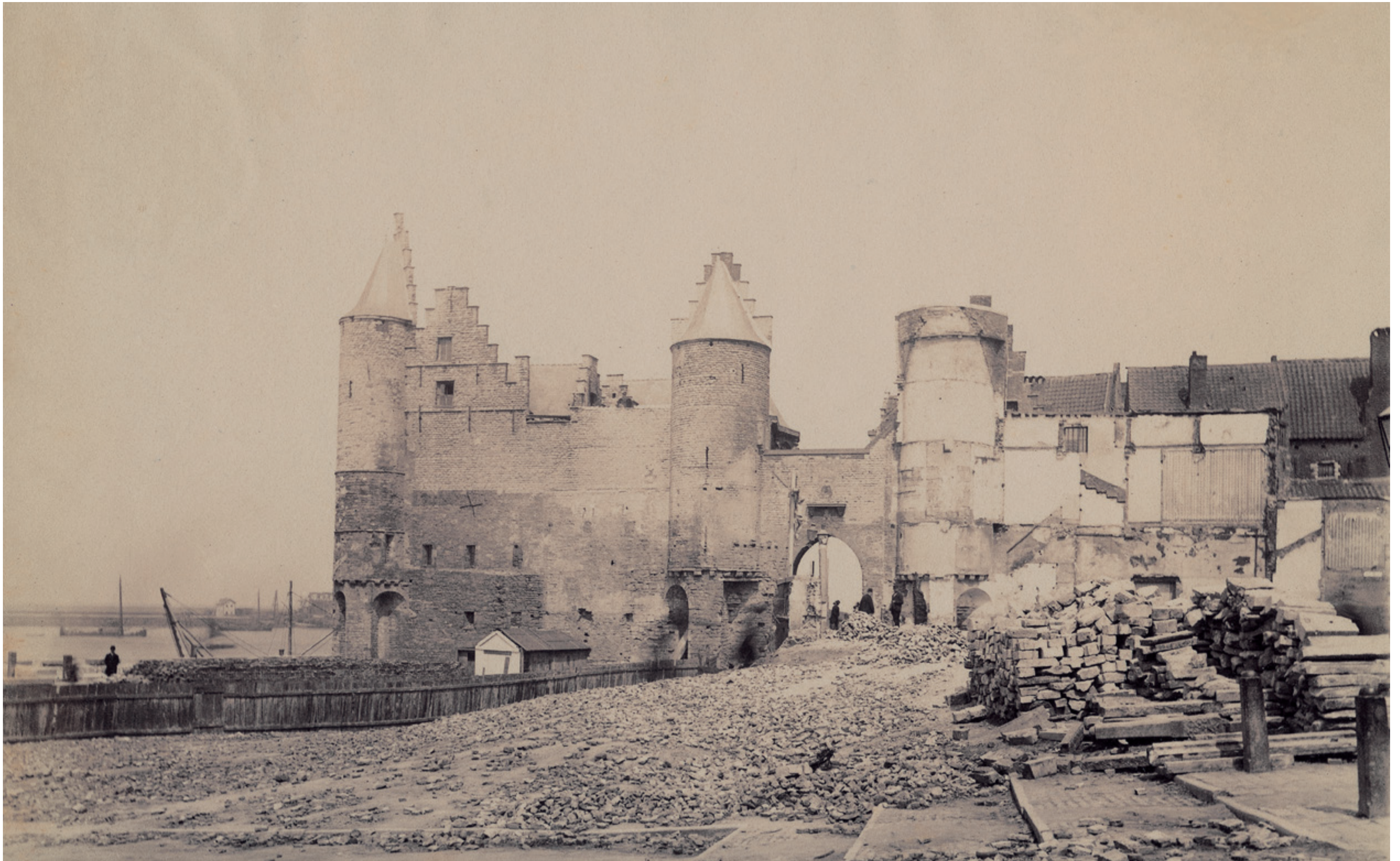
215. Fotograaf onbekend. Het Steen na de afbraakwerken
