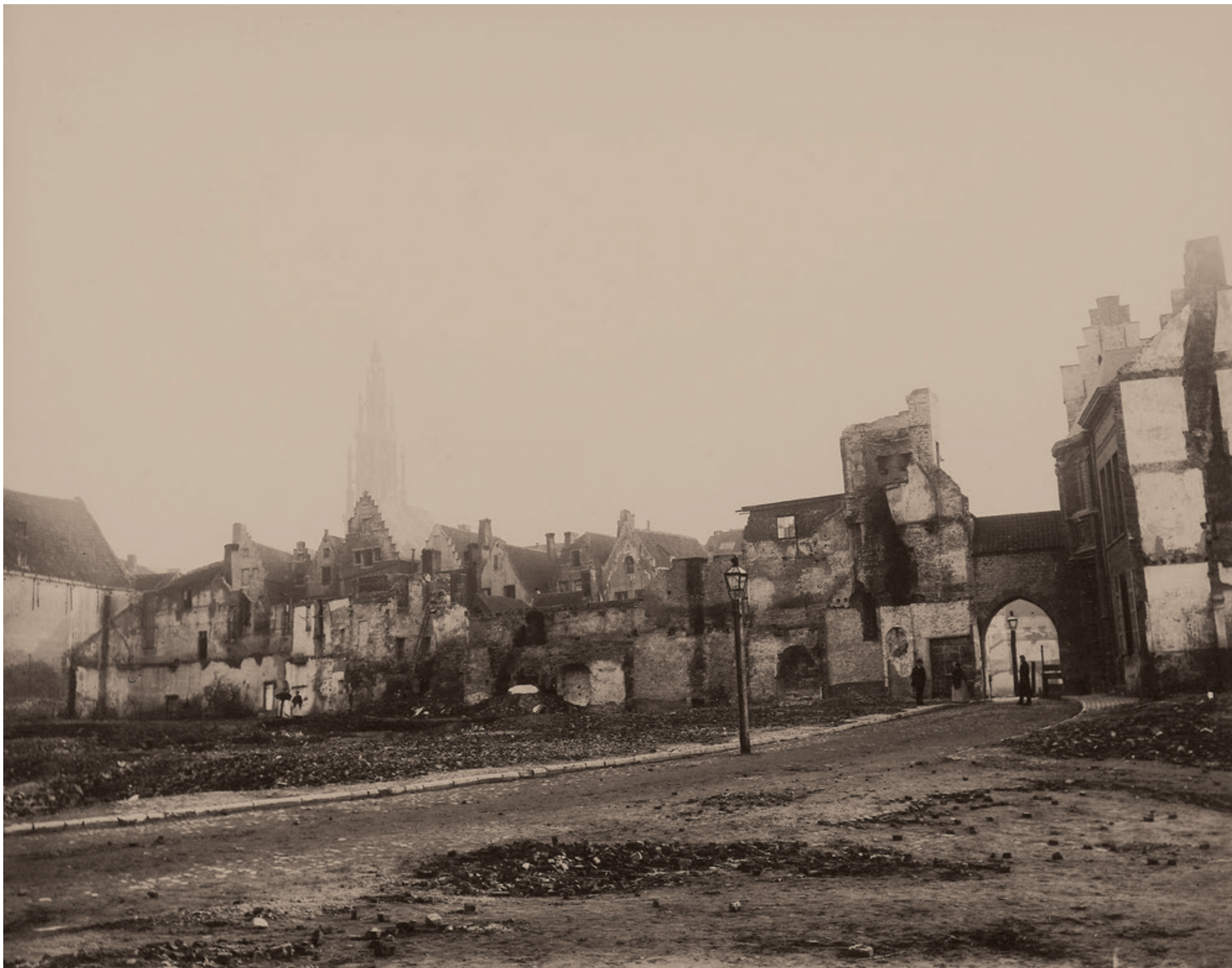
222. Fotograaf onbekend. Afbraakwerken in de buurt van het Steen
