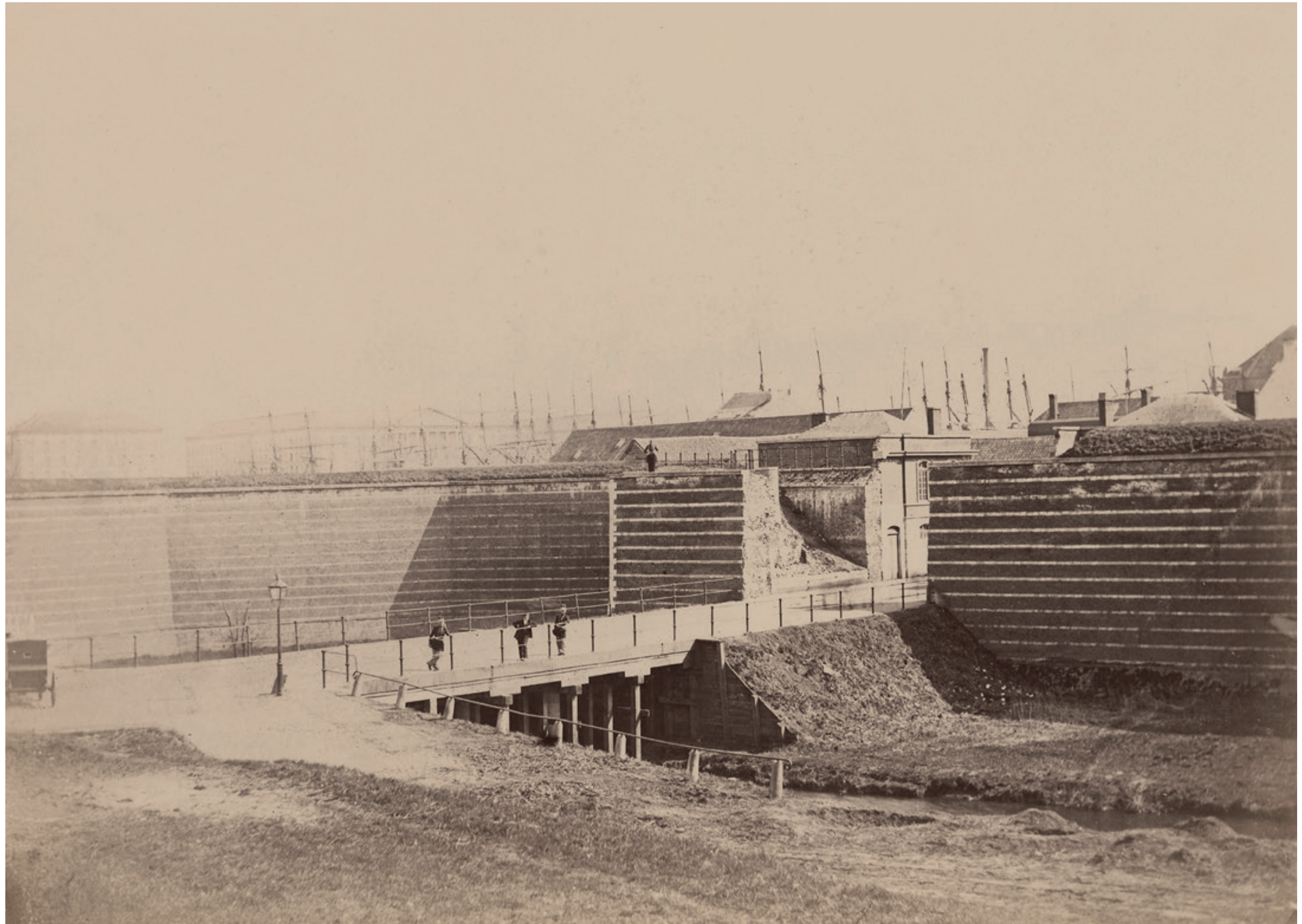
16. Florent Joostens. Lillopoort, buitenkant, overgang tussen Bonaparte- en Willemdok, 1863-1864
