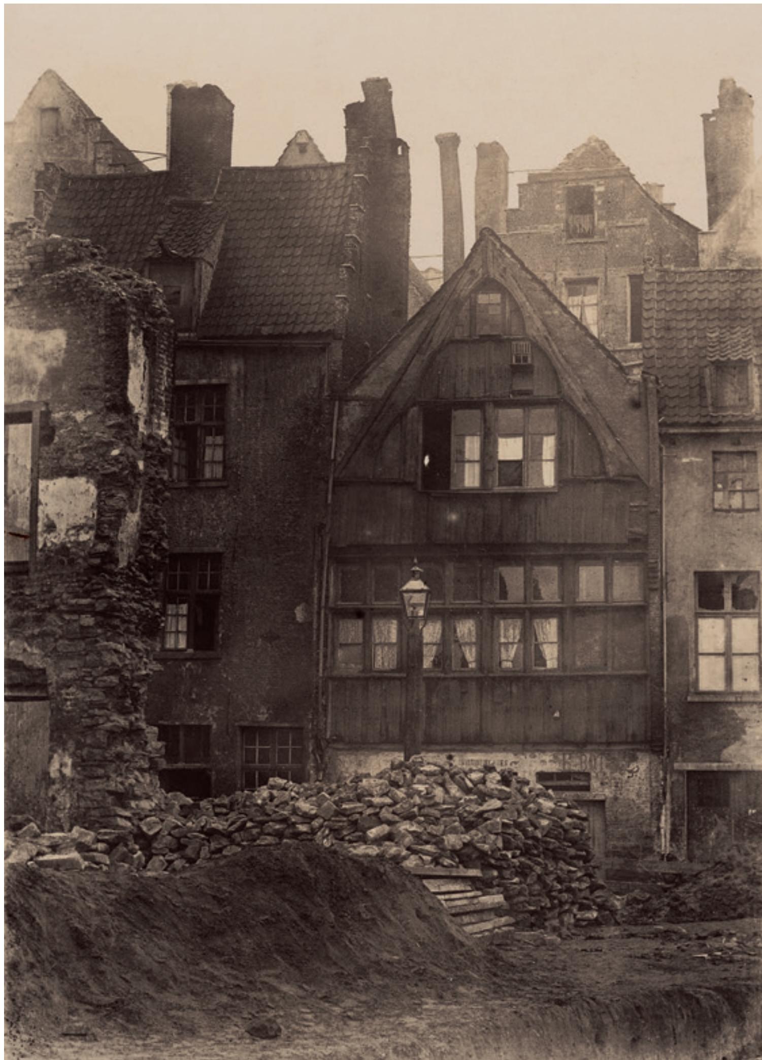
224. Fotograaf onbekend. Houten gevel aan Palingbrug tijdens afbraakwerken
