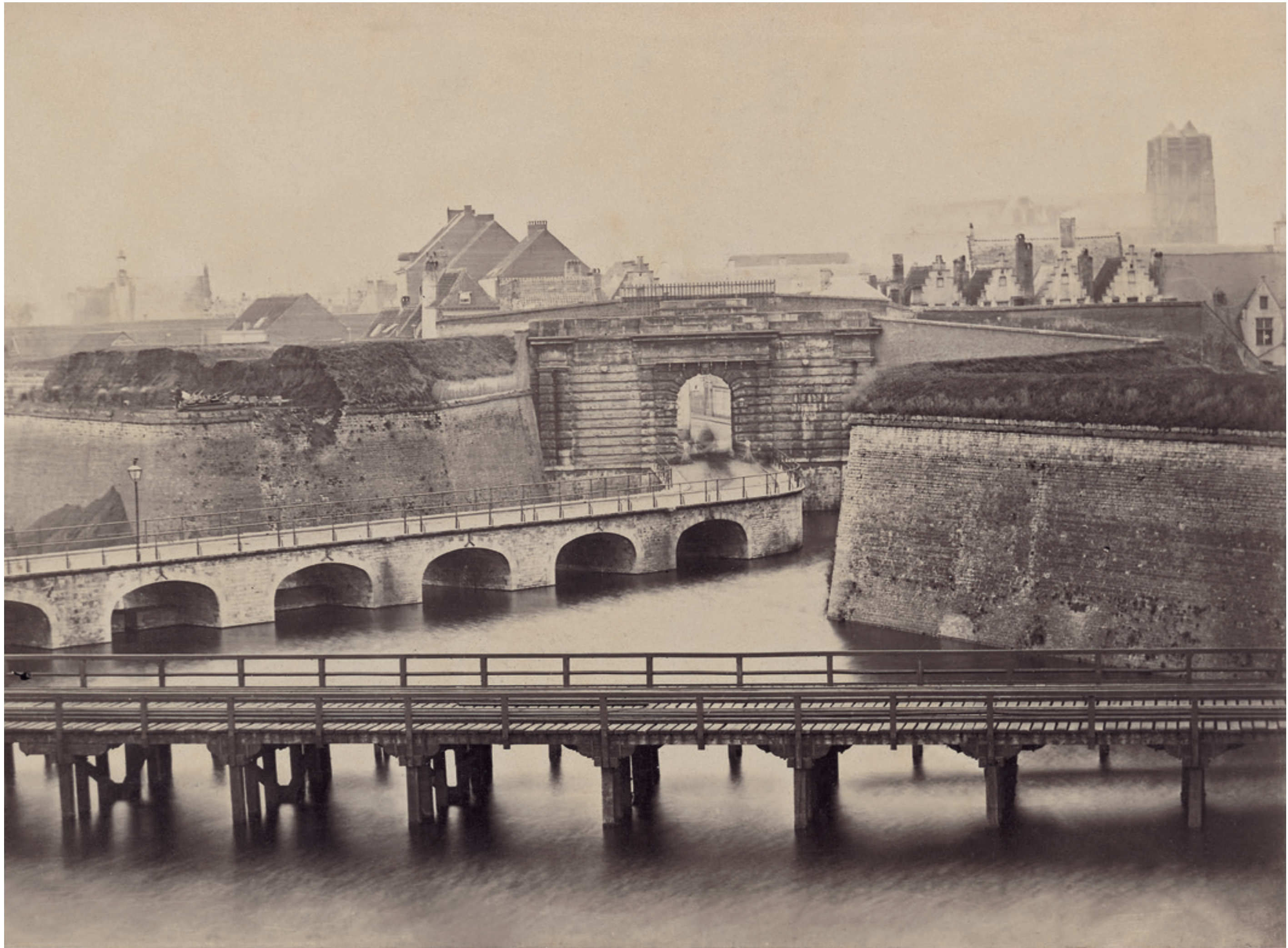
27. Florent Joostens. Rode Poort, begin van de afbraak, 1865-1866
