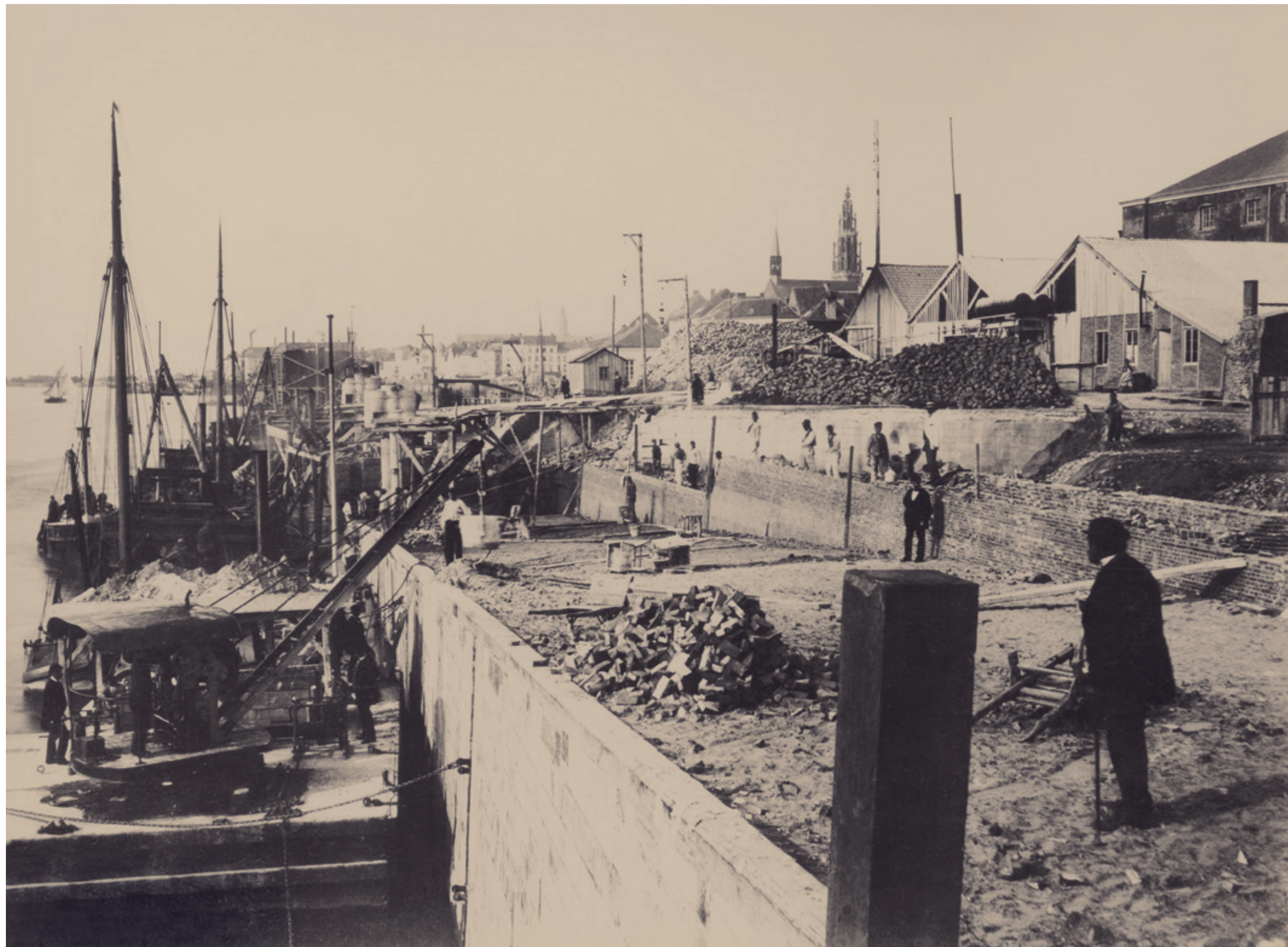
229. Fotograaf onbekend. Aanleg van nieuwe kaaien, zuidkant van de stad
